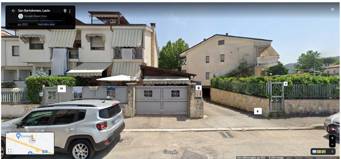
FOTO 53: VIA NILDE IOTTI 4, 8, 10 (ABITAZIONI PALAZZINA N) 6 (GARAGE)
