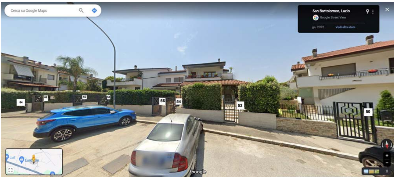
FOTO 18: VIA MONTESSORI 50, 52, 54, 56, 58, 60, 62 (ABITAZIONI – PALAZZINA L), 64 (GARAGE)
