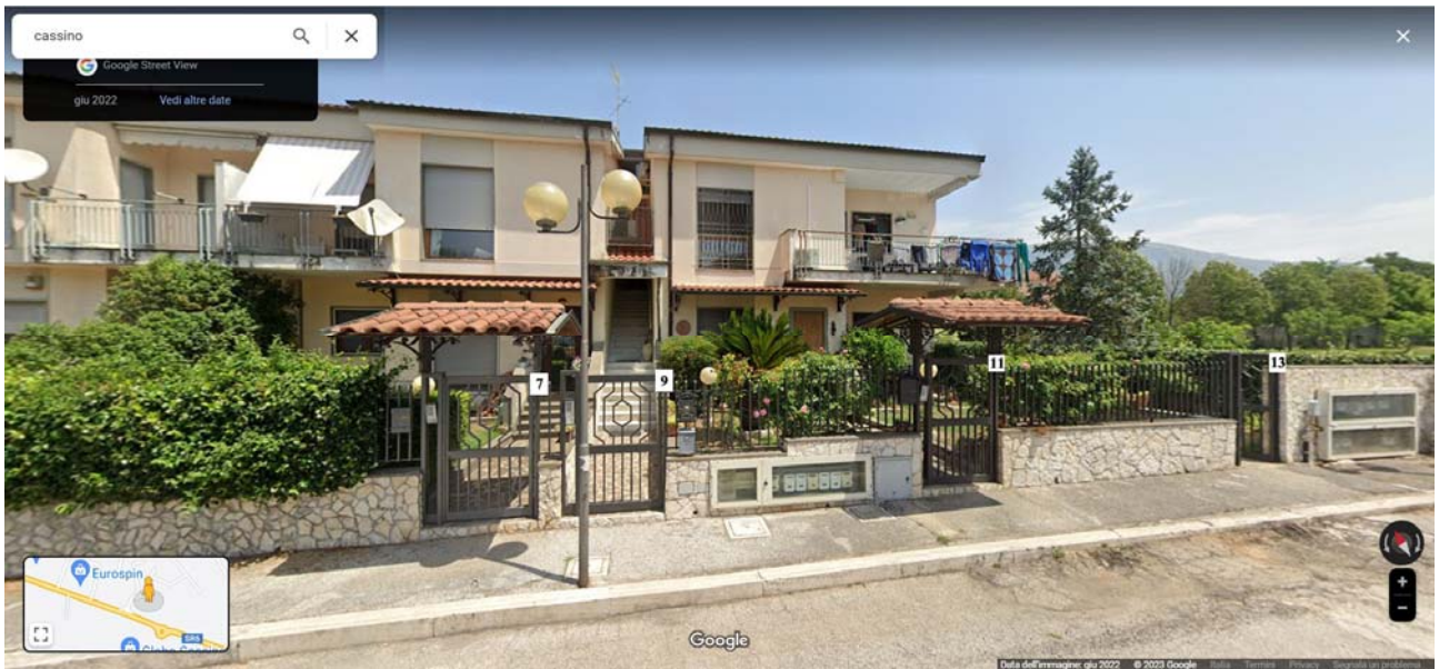
FOTO 63: VIA GRAZIA DELEDDA 7, 9, 11, 13 (ABITAZIONI – PALAZZINA O)
