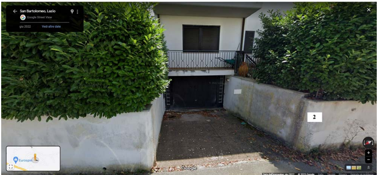
FOTO 67: VIA MATILDE SERAO 2 (GARAGE PALAZZINA Q)
