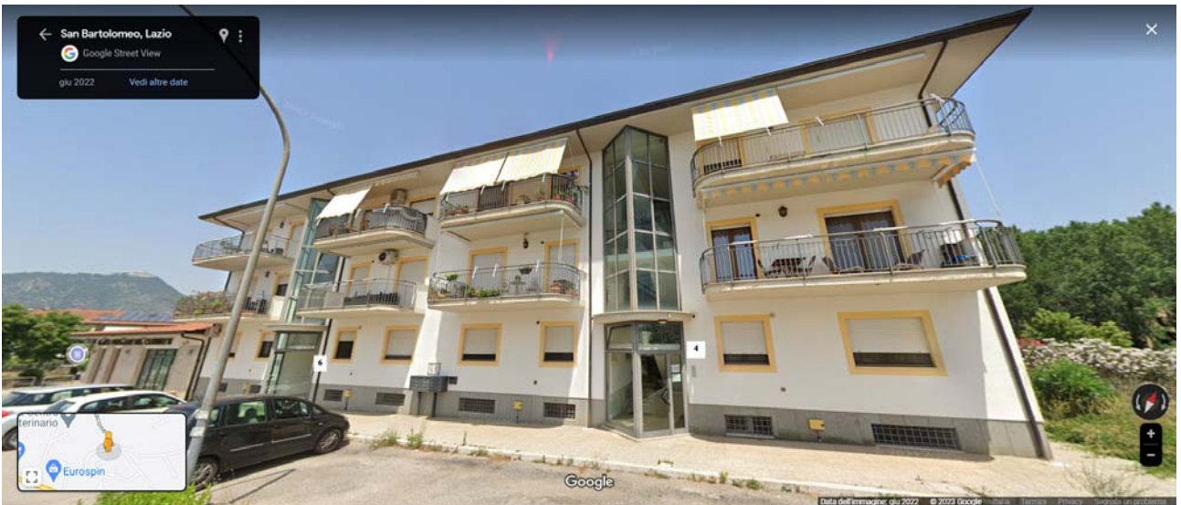
FOTO 10: VIA MONTESSORI 4, 6 (CONDOMINIO PALAZZINA A )
