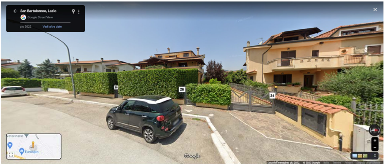
FOTO 13: VIA MONTESSORI 24 (INGRESSO CARRABILE), 26, 28 (ABITAZIONI)
