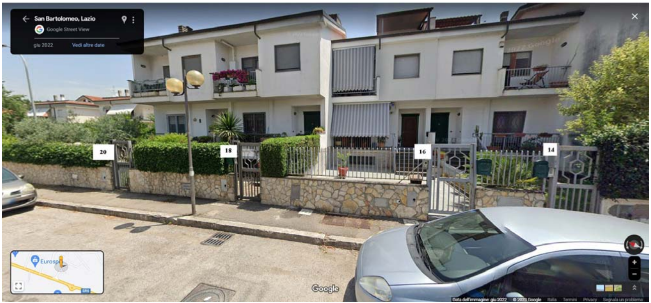
FOTO 56: VIA NILDE IOTTI 14, 16, 18, 20 (ABITAZIONI PALAZZINA N)
