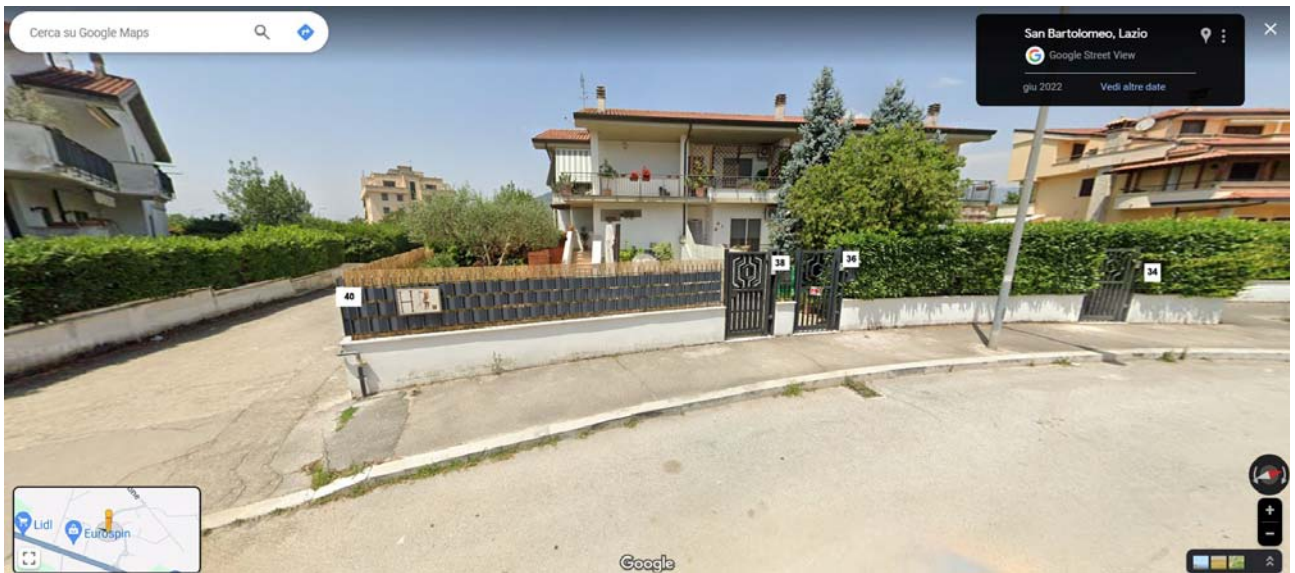
FOTO 16: VIA MONTESSORI 34, 36, 38 (ABITAZIONI – PALAZZINA H), 40 (GARAGE)
