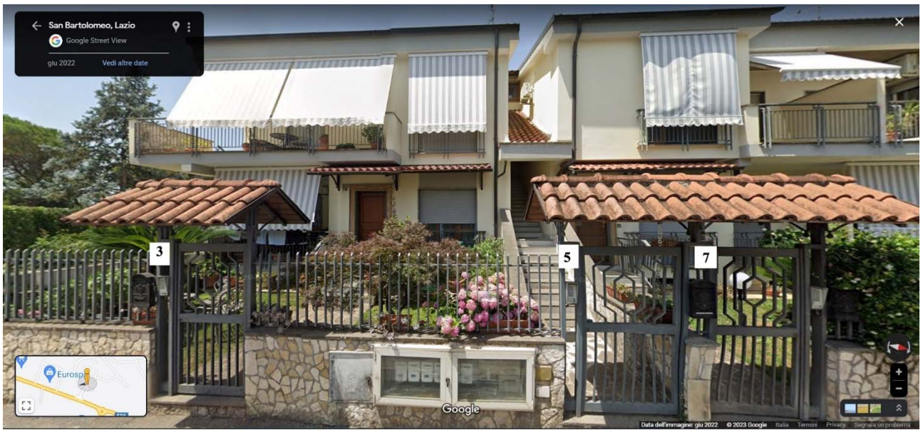
FOTO 52: VIA NILDE IOTTI 3, 5, 7 (ABITAZIONI PALAZZINA M)
