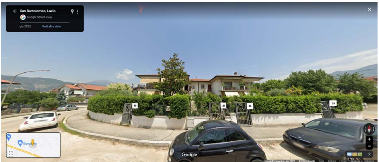
FOTO 5: VIA MONTESSORI 19, 21, 23, 25 (ABITAZIONI – PALAZZINA S)
