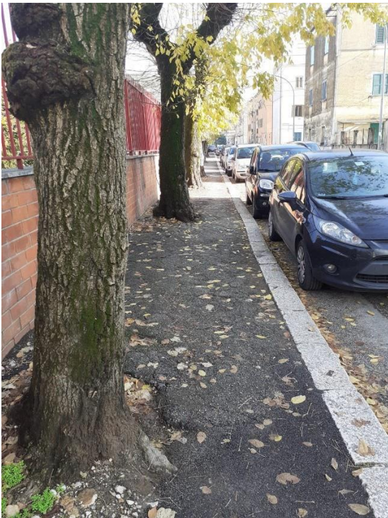
Marciapiede su via V. Grosso
