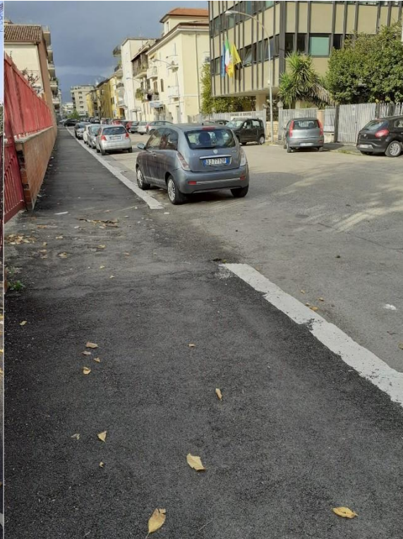
Marciapiede su G.B. Vico
